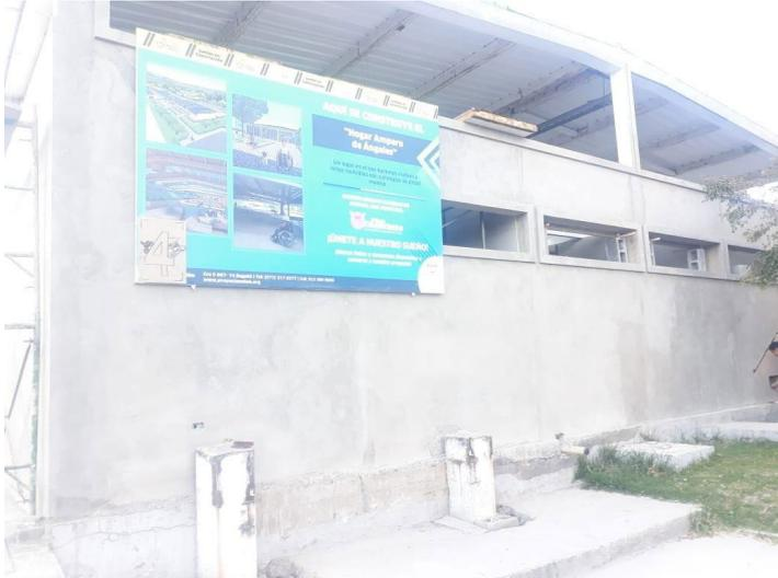
*Die Außenwände des gesamten Gebäudes sind verputzt und die Fensterrahmen fertiggestellt.*
