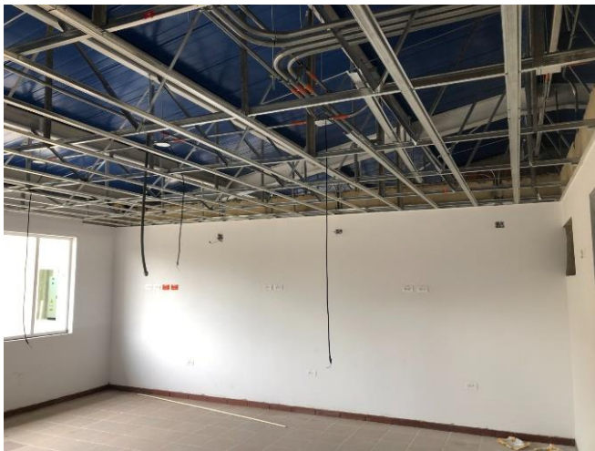
Einbau der Stromleitungen, Belüftungs- und Brandschutzsysteme (Juni 2022).
