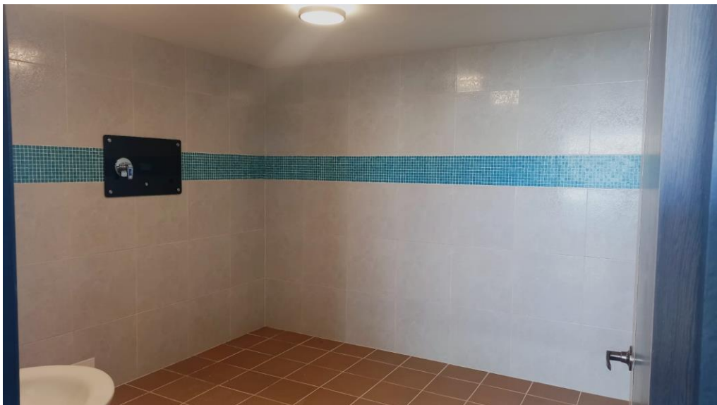
Bis zu fünf Kinder haben in dem Zimmer Platz. Das Zimmer mit Bad ist wie das gesamte Gebäude barrierefrei und bietet Platz für Pflegebetten und Rollstühle.
